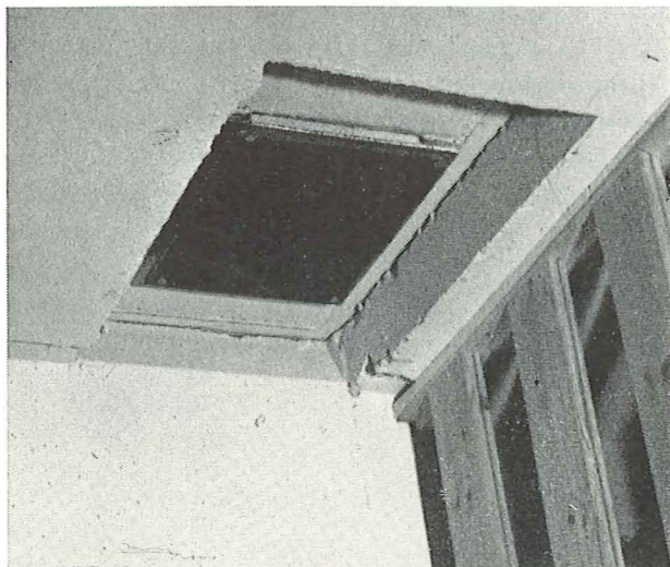
Fig. 5. Billedet viser, hvorledes en aftagelig renselem er anbragt i bunden af en større ventilationsskakt i en boligbloks kælder.
